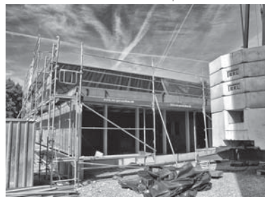
Ein Gemeindehaus entsteht!
